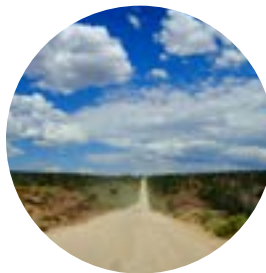
可通行的66号公路非铺装路段 (343号出口至346号出口)
